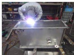
写真⑥・・・「ATFタンク」溶接作業
