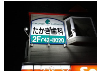
既存は4灯(164W)でしたが、LEDに交換した際2灯(38w)で点灯したところ、交換前の明るさとあまり変わりませんでした
