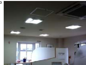
既存は4灯(164W)でしたが、LEDに交換した際2灯(38w)で点灯したところ、交換前の明るさとあまり変わりませんでした
