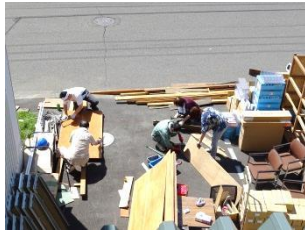
不要となった木材の釘抜き作業
