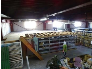
中二階の解体作業中
