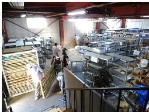
中二階解体後の棚移動
