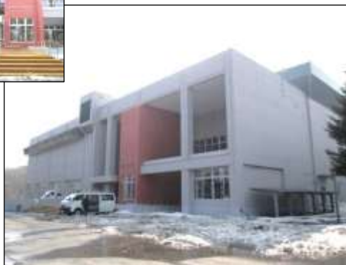
玄関には 自動ドア エレベーターも新設
